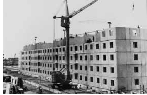
Строительство пятиэтажного жилого дома. Город Волжский
