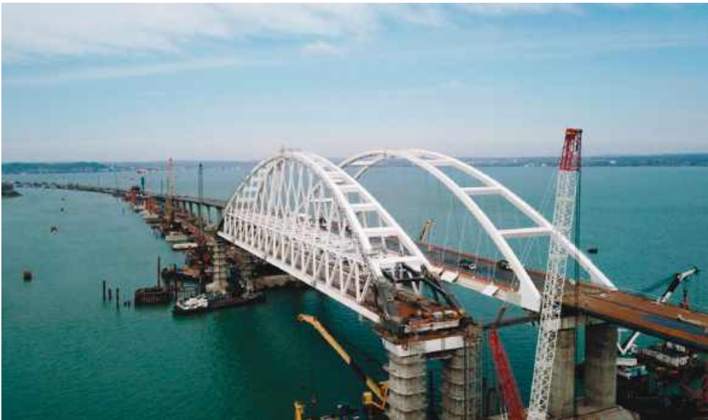
Строительство Крымского моста через Керченский пролив. Март 2018 г.
