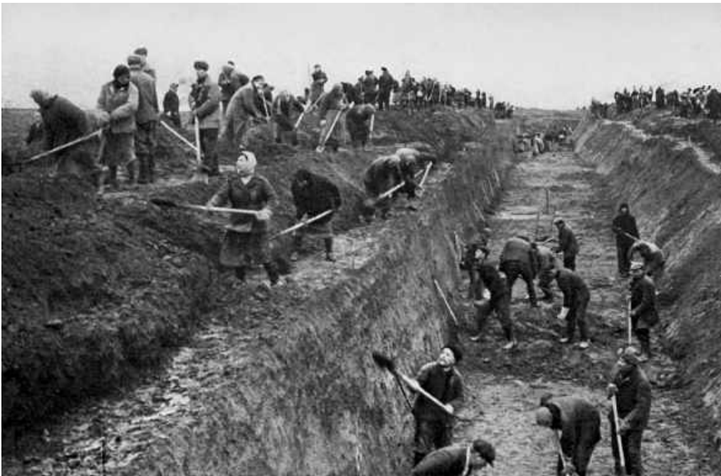
Строительство оборонительных сооружений под Москвой. Осень 1941 г.
