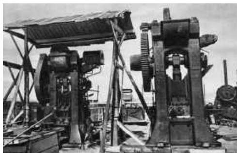
Монтаж оборудования на эвакуированном заводе. Казахстан. 1942 г.
